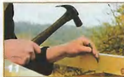
11 Гвозди забивают наискось и при креплении поперечин для пола наблюдательного мостика.
