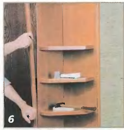
Декоративные раскладки можно устанавливать в распор, слегка надавливая на панели.
