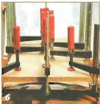
6 Сращенный лист шпона накладывают на плиту-основу и временно скрепляют струбцинами, подложив под них ДСП.
