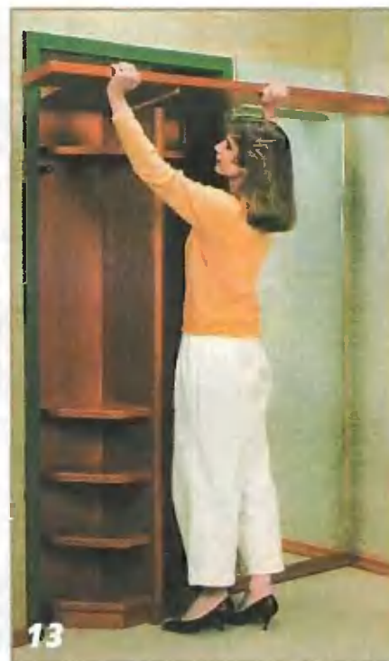
Вторым концом полка опирается на брусок (который желательно укрыть), прикрепленный к стене справа.
