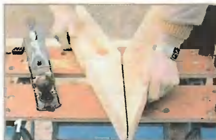
Верхнюю часть стоек запиливают «на ус».
