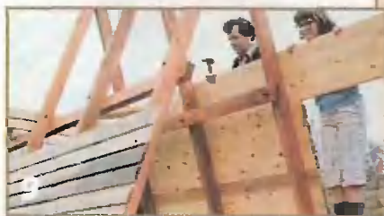
9 Крышу можно покрыть шпунтованными досками.
