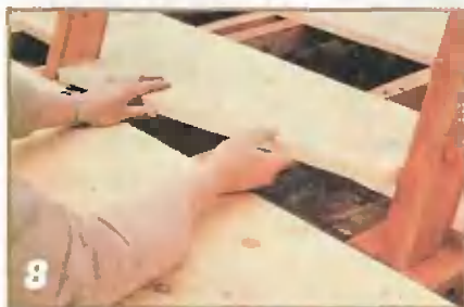
8 Подгонка досок, настилаемых между стойками.
