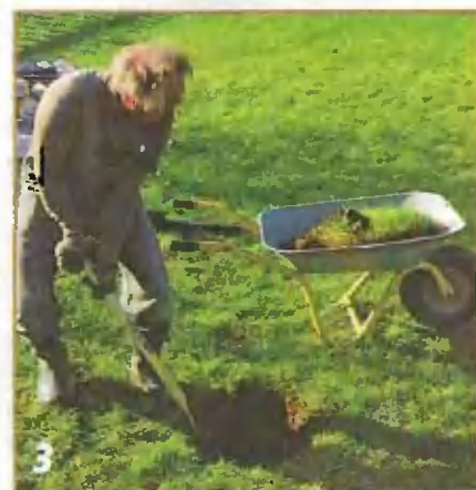
3 Под анкеры выкапывают ямы глубиной порядка 70 см.
