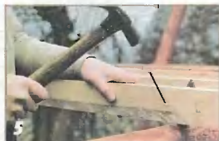
Нижние продольные балки крепят гвоздями, забивая их наискось.
