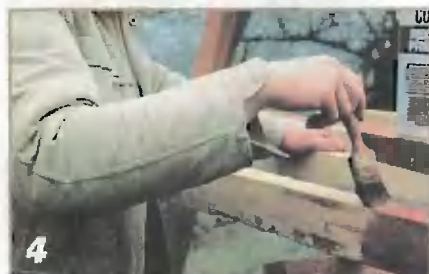
Детали каркаса можно обработать защитным средством до сборки.
