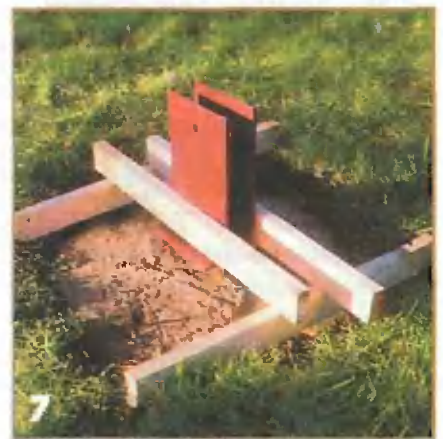
7 ... его временно подвешивают на простейшей конструкции из брусков.
