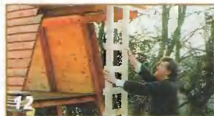
12 Крепление лестницы наблюдательной вышки.
