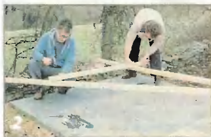
Попарно стойки А-образного элемента скрепляют поперечинами.
