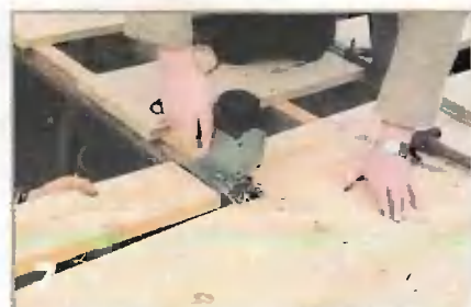
Раскрой половых досок по длине.
