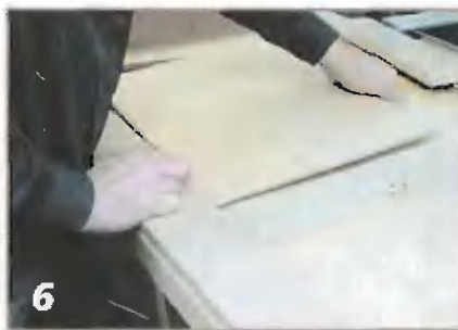
Фанерные филенки сначала устанавливают в раму насухо.
