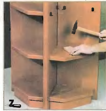
При необходимости осадить деталь во время монтажа используют прокладку.
