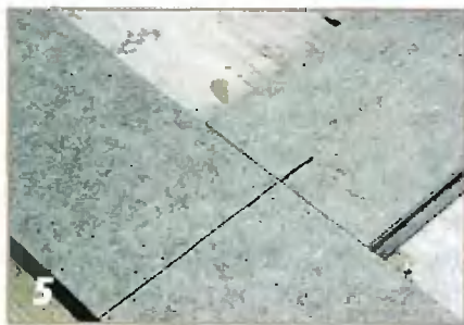
На горизонтальных обвязках рамы отмечают положение всех стоек.
