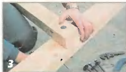
Гайки соединительных болтов пока затягивают от руки.
