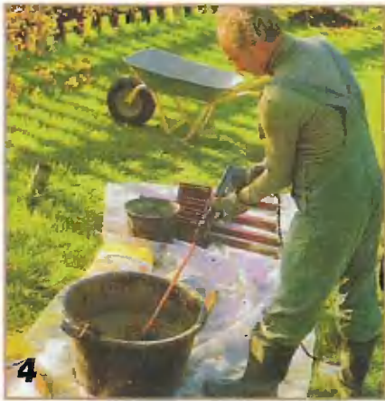
4 Для перемешивания раствора используют «веселку», закрепленную в патроне электродрели мощностью не менее 400 Вт.
