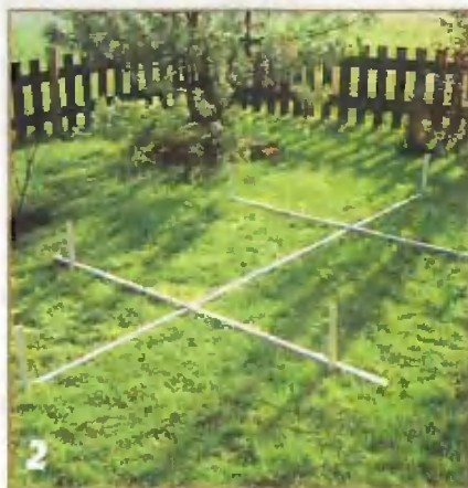
2 Теперь можно произвести разметку точек, где будут установлены анкеры.
