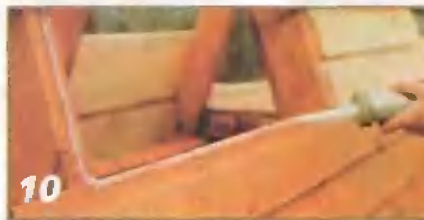
10 В оконный проем вставляют акриловое стекло, закрепляя его силиконовой массой.
